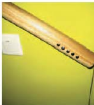
Fra Iris-bygget i Helsinki: Markering på gelender gjør det enkelt å vite hvilken etasje man er kommet til.
