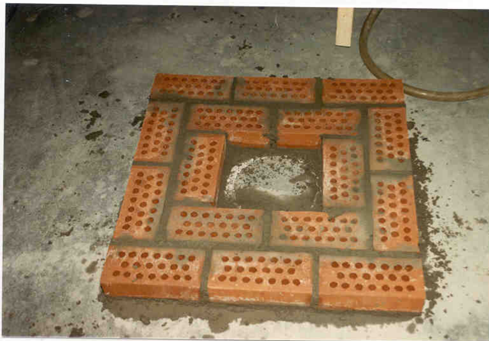
Fig. 3: Skift 1 fra oppmuring av pipen.
