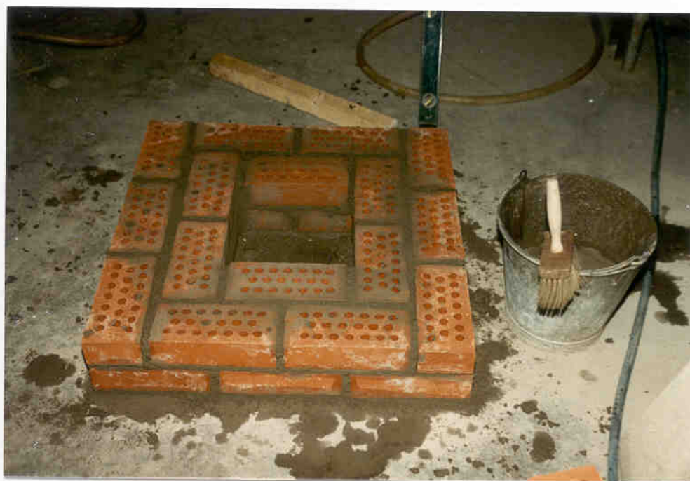
Fig. 4: Skift 2 fra oppmuring av pipen.
